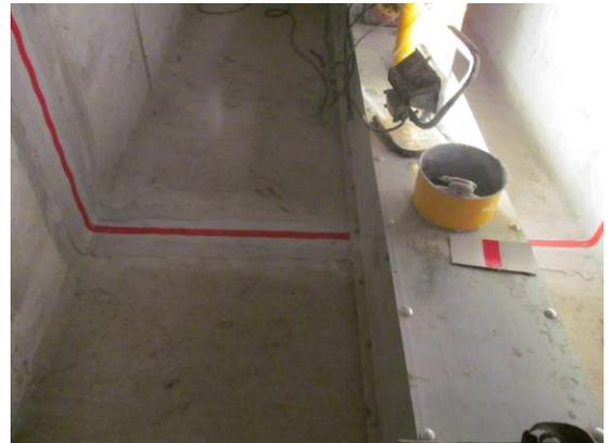
6. Закрытие ленты металлической полосой для защиты от механических повреждений.
